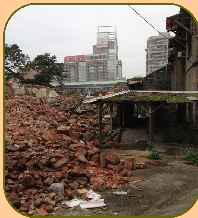
鐵道部屋舍拆除後
