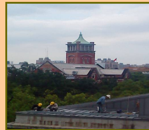
南門樟腦部屋頂工程
