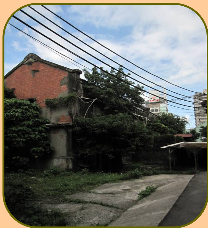
鐵道部屋舍拆除前
