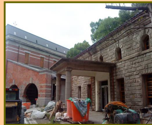
南門園區樟腦部修復工程
